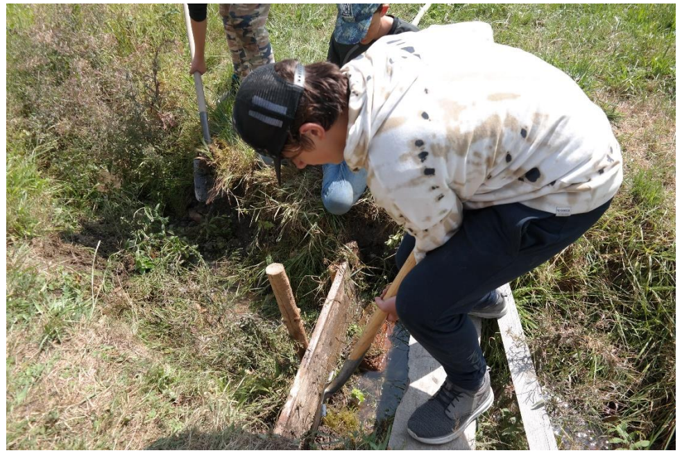
Bau eines Staudamms
